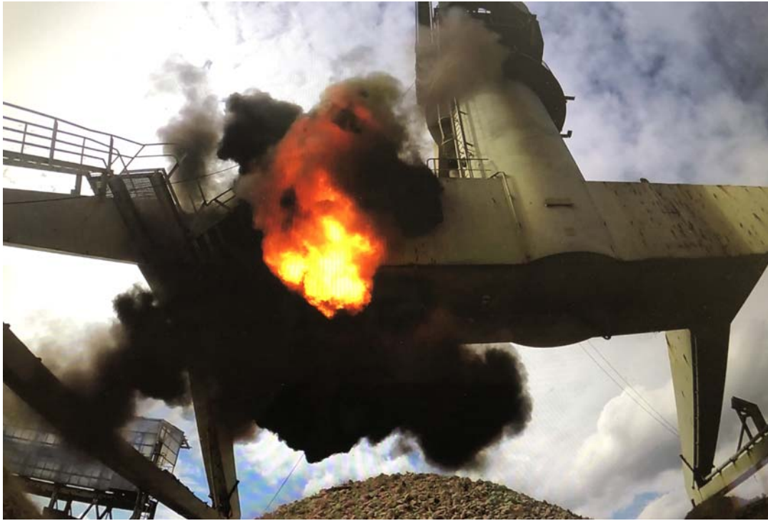
Figuur 32: Impressies sloop havenkraan met explosieven.
