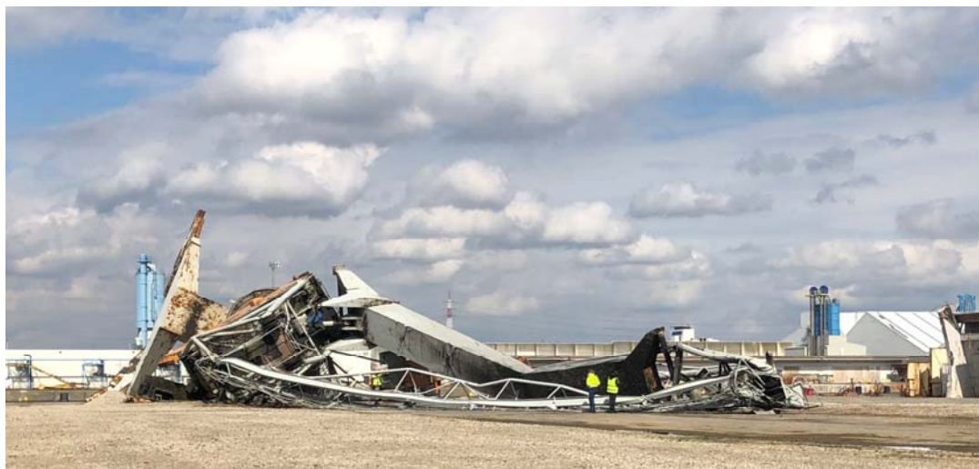
Figuur 31 : Impressies sloop havenkraan met explosieven.
